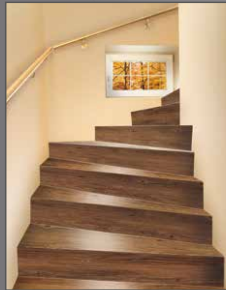
Verkleidung mit Treppenkanten bei einer innenliegenden Treppe
